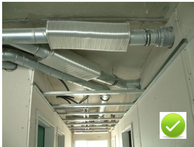
Abbildung 24: Strömungsgünstige und reinigungsfreundliche Ausführung mit 45°-Abzweiger
