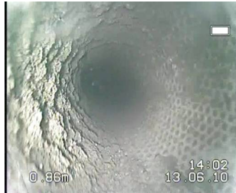
Abbildung 38: Abluftleitung, Schalldämpfer
