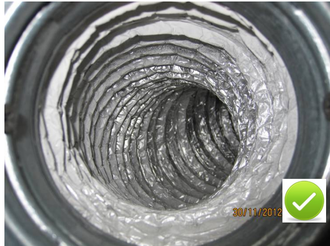
Abbildung 28: Abluftleitung nach Abluftdurchlass. Keine Verunreinigung sichtbar.
