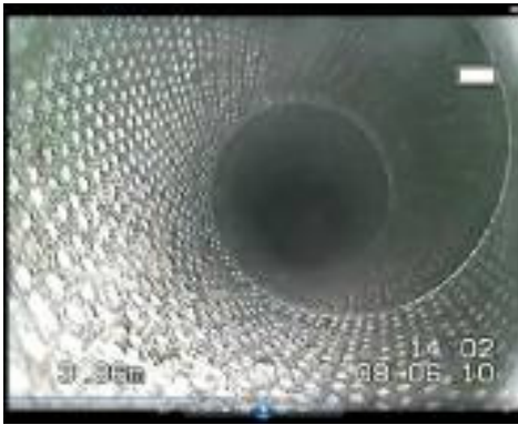
Abbildung 37: Abluftleitung, Schalldämpfer
