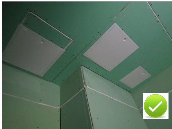
Abbildung 34: Revisionsöffnungen
