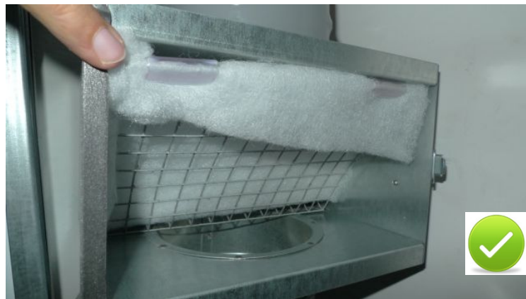
Abbildung 22: Filter richtig positioniert Die Strömungsrichtung erfolgt hier von oben nach unten.
