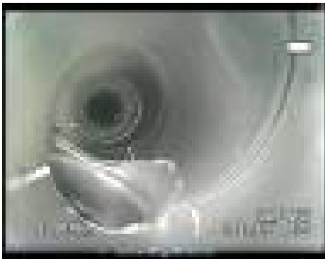
Abbildung 44: Zuluftleitung, Abzweiger
