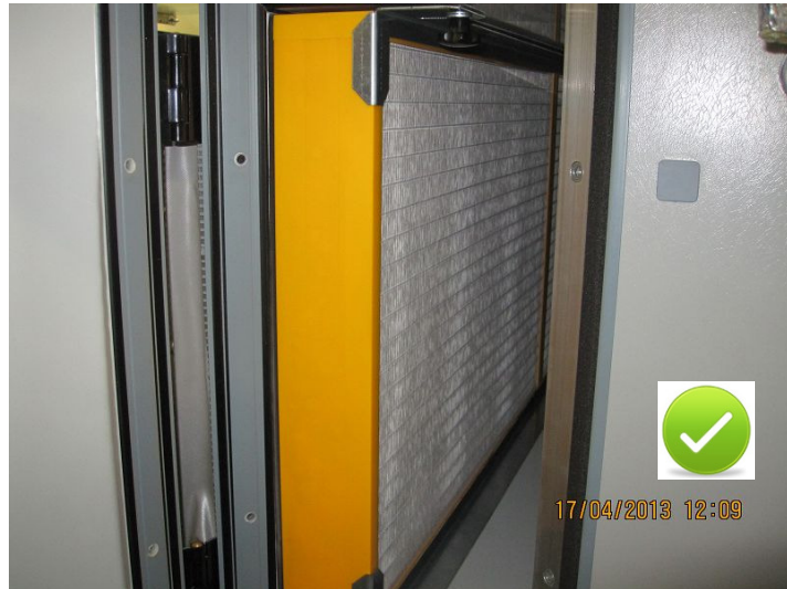
Abbildung 19: dichter Filtersitz
