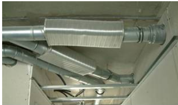
Abbildung 83: vorteilhafte Verwendung von 45°- Bögen und 45°-Abzweigern
