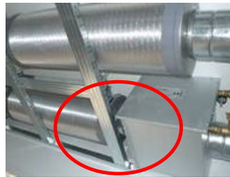
Abbildung 27: keine Zugänglichkeit nach Heizregister
