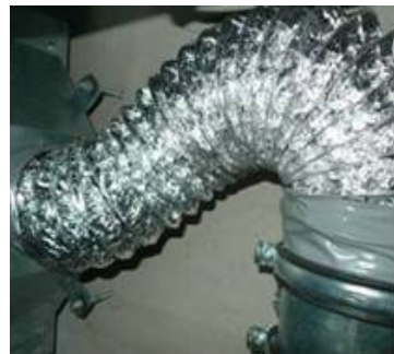
Abbildung 13 und 14: nicht zulässige Folienschläuche, Innen- und Außenansicht
