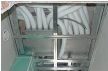
Abbildung 28: ungünstige, enge Einbausituation, kein Trockenbau-Revisionstüren vorgesehen
