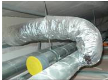
Abbildung 11 und 12: nicht zulässige „Schalldämm-Folienschläuche“, Innen- und Außenansicht
