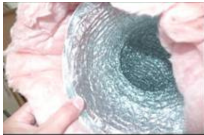
Abbildung 11 und 12: nicht zulässige „Schalldämm-Folienschläuche“, Innen- und Außenansicht
