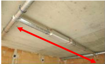
Abbildung 26: nicht reinigbarer Abschnitt
