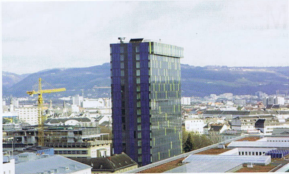
Der Power-Tower der Energie AG in Linz gilt als weltweit erstes Bürohochhaus mit Passivhaus-Charakter und ist mit dem ÖGNI-Label in Gold zertifiziert.
