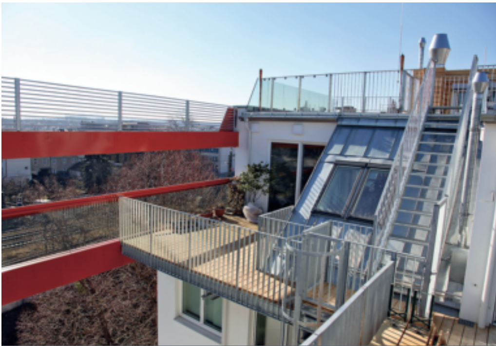
Das ausgebaute Dach hat Qualitäten
